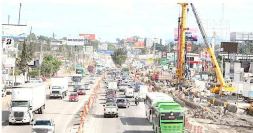
■ La colocación de concreto hidráulico en la Carretera a Chapala concluirá en diciembre próximo.
