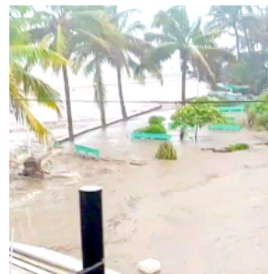
Continúan con la revisión de daños e para integrar la documentación.
