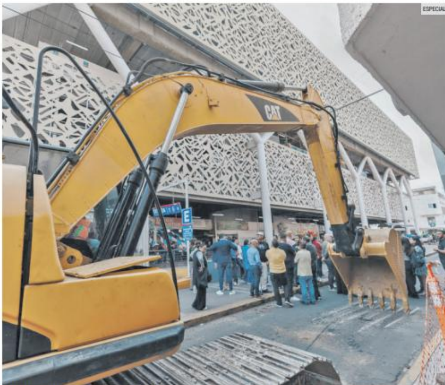
BUEN INICIO. Maquinaria pesada realiza trabajos de sustitución de pavimento frente al Mercado Corona, como parte de las obras de rehabilitación que el Gobierno de Guadalajara inició en calles del Centro Histórico.
