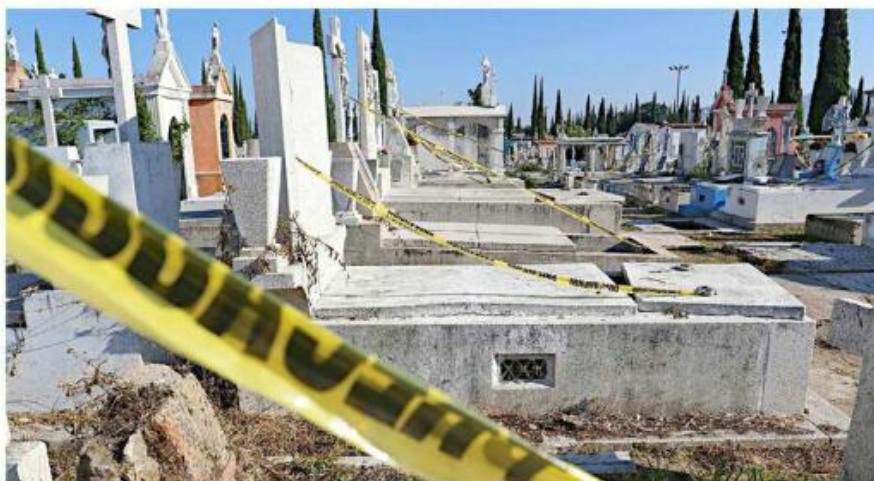
■ Algunas tumbas lucen deterioradas y con cintas de seguridad.
