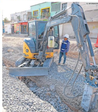
OBRAS EN MARCHA. Trabajadores de la construcción llevan a cabo la instalación de vías de las nuevas líneas del Tren Ligero.
