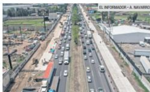
CARRETERA A CHAPALA. Se abrirá el 20 de noviembre.
