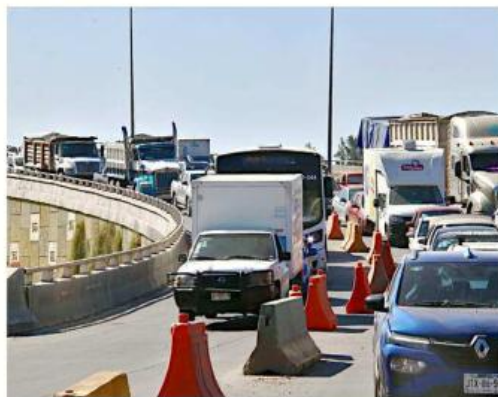
■ Las obras en curso generan tráfico en la zona, desde el puente de la fábrica de Maseca hasta Periférico.
