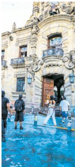
DAÑOS EN PALACIO DE GOBIERNO. Cristales rotos y puertas derribadas.
