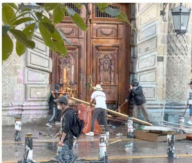
Puertas, ventanas, algunos mobiliarios en algunas oficinas y más, fueron dañados.
