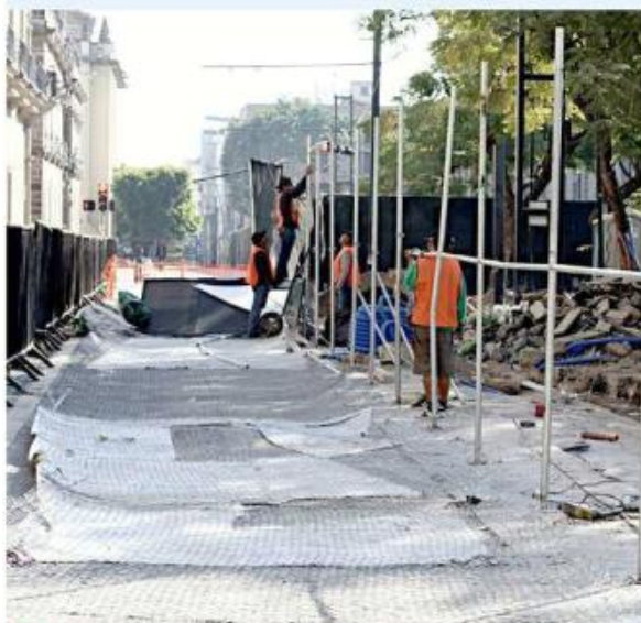
■ Durante la manifestación del pasado sábado se sustrajo material y herramientas de la obra de remodelación de Plaza Liberación.
