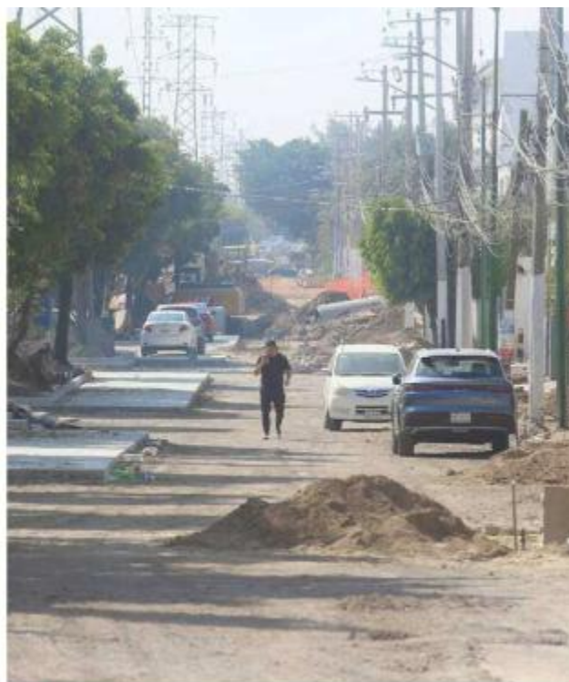
■ Se proyecta que las obras de renovación de la vía con concreto hidráulico concluyan en diciembre.
