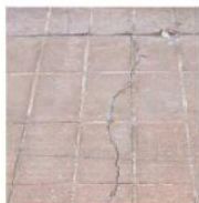
Cuarteaduras en los pisos recién remodelados de Plaza de la República.
