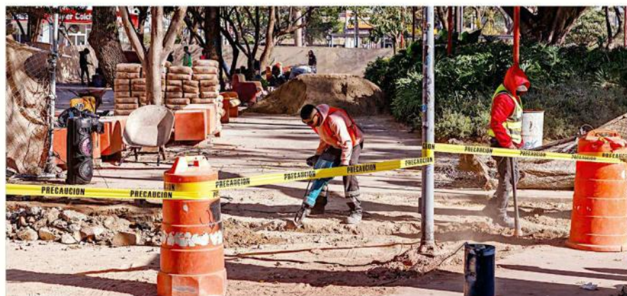
■ En el parque se observan trabajadores realizando labores en distintas áreas.
