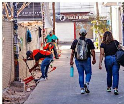
■ En la Calle Marcos Castellanos se trabajaba en las banquetas.
