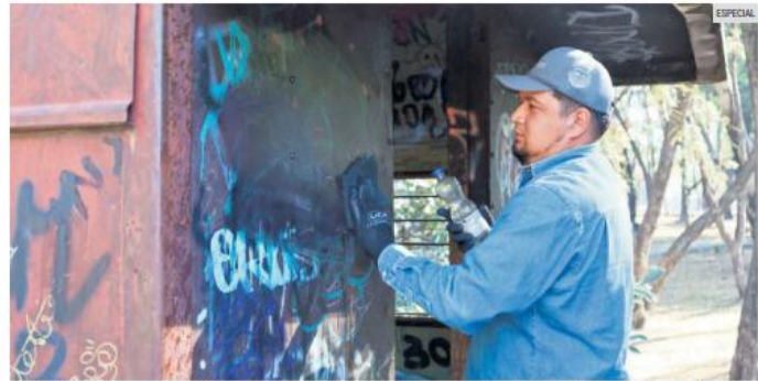
TRABAJOS. Personal especializado retira grafiti con técnicas que protegen la estructura y el valor patrimonial de la pieza.
