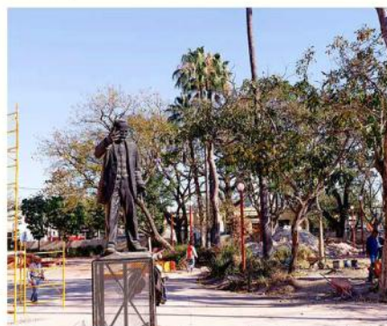
■ En la zona de la Avenida Juárez se realizan diversos trabajos.
