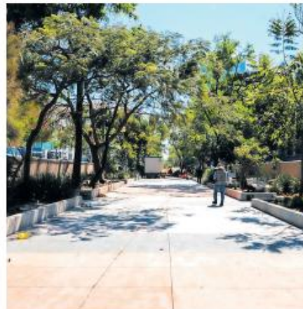
Casi terminado el corredor Chapultepec.
