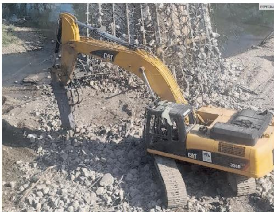
ESTALLIDO. Una grúa retira escombros del Puente La Desembocada, tras la explosión registrada durante las labores de demolición en Puerto Vallarta.
