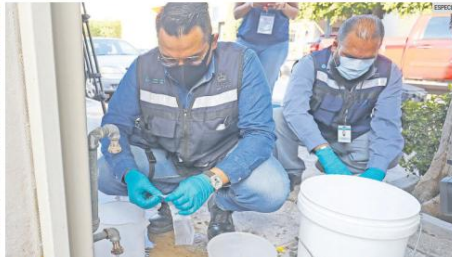
SOLUCIONES. El agua turbia y con mal olor en las colonias se atribuye al deterioro del sistema antiguo de conducción y a los trabajos de desazolve, informó el SIAPA. Si el problema persiste, pide reportarlo al 073.
