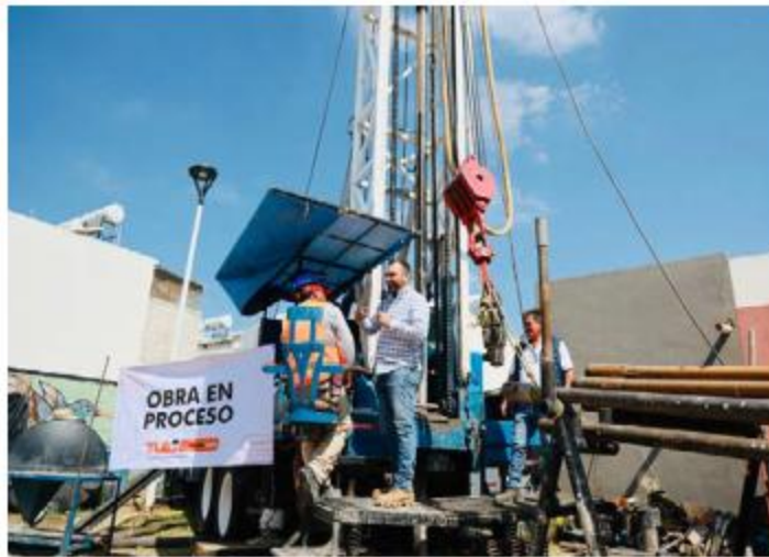
ARRANQUE. Con una inversión de 200 mdp, el alcalde de Tlajomulco, Gerardo Quirino Velázquez, arrancó la construcción de un nuevo pozo profundo en el fraccionamiento Los Abedules.
