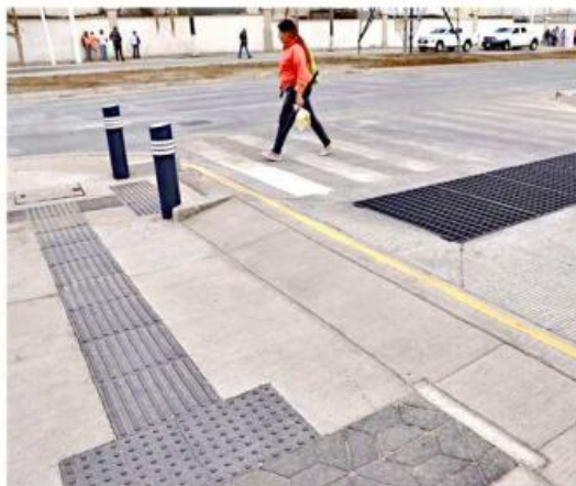
■ Tras la obra se dejaron banquetas con accesibilidad universal.
