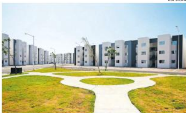
ZONA. En la primera etapa del proyecto se rehabilitaron 735 viviendas dentro de Arbolada del Mirador.
