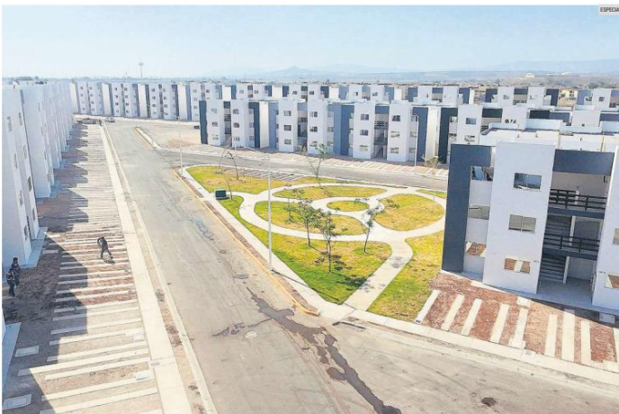
ARBOLADA DEL MIRADOR. Con un nuevo nombre, el Chernóbil quedó atrás con la transformación del complejo habitacional. Ahora luce rehabilitado, con servicios públicos, infraestructura, seguridad y nuevas familias habitándolo.
