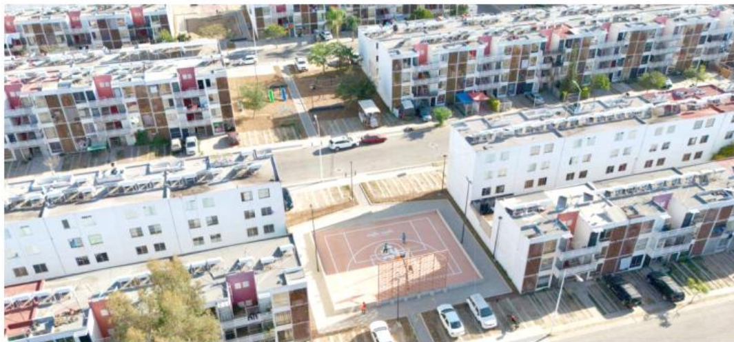
Se colocaron vasos reguladores, áreas de juegos infantiles, cancha de fútbol, andadores peatonales y un salón de usos múltiples.
