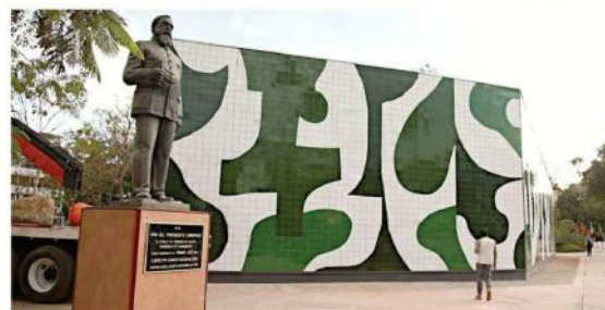
A la entrada de la estación del tren ligero se le incorporaron mosaicos en tonos de verde y blanco.
