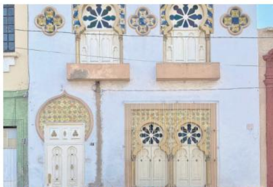
VISTA DE HERRERA Y CAIRO 361. Los patrones geométricos son notables en su fachada.
