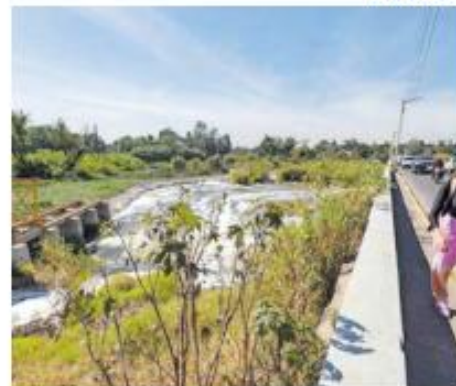
AFLUENTE CONTAMINADO. Los estudios se realizan en comunidades asentadas a lo largo del río Santiago.
