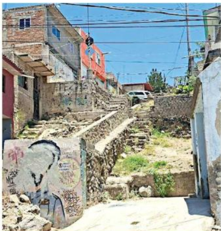
A falta de pasamanos, vecinos tienen que utilizarlas con extrema precaución para evitar accidentes.
