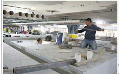
Se intervino la fuente porque peligraba la estructura de la misma, así como la del estacionamiento.
