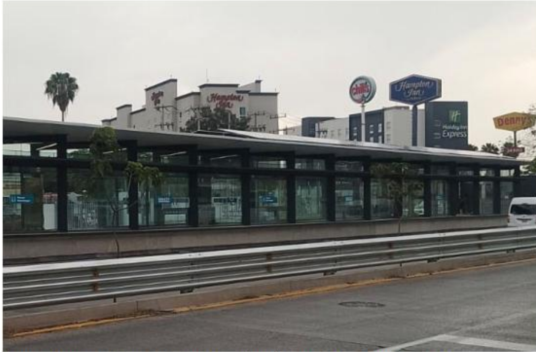
Las estaciones del sistema de transporte están prácticamente terminadas. MILENIO
