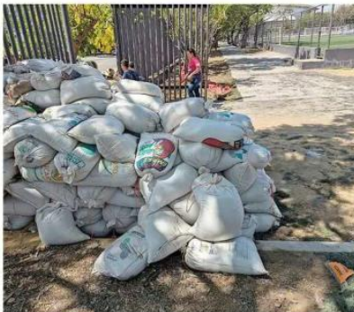
La salida hacia Calle 2 luce saturada de costales con aserrín.
