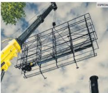
CORREDOR. En distintos puntos de Avenida Patria, cuadrillas especializadas trabajan con grúas de gran capacidad para retirar espectaculares.
