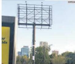
AMPLIACIÓN. Las labores de desmontaje de anuncios continúan en Avenida Américas.
