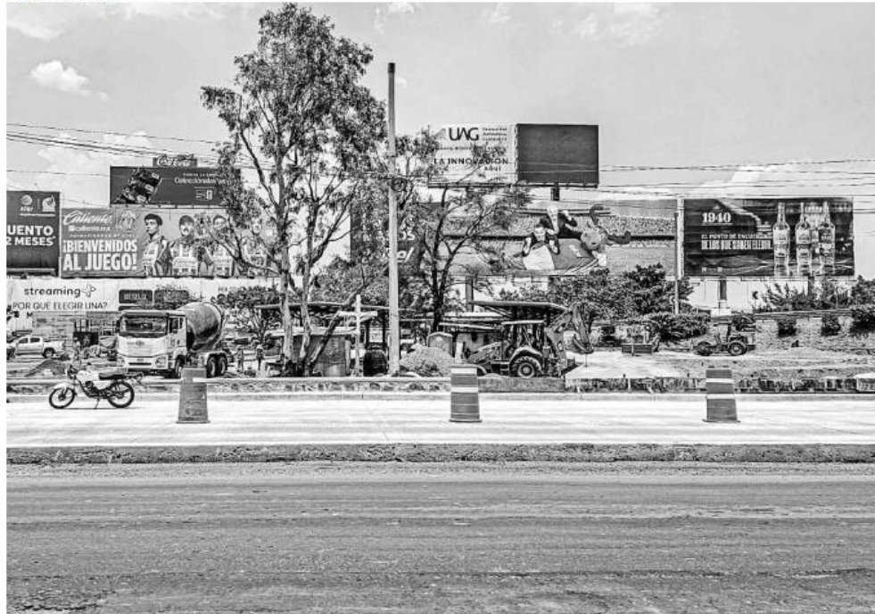
A contrarreloj trabajan para terminar las obras por carretera a Chapala.
