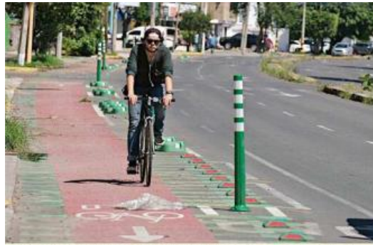
Se intervendrán siete ciclovías ubicadas en este sector de la Ciudad.
