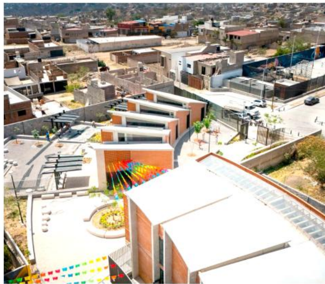
Cuenta con una superficie de cuatromil 813 metros cuadrados.
