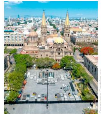
La Plaza Liberación ya tiene movilización de montaje.
