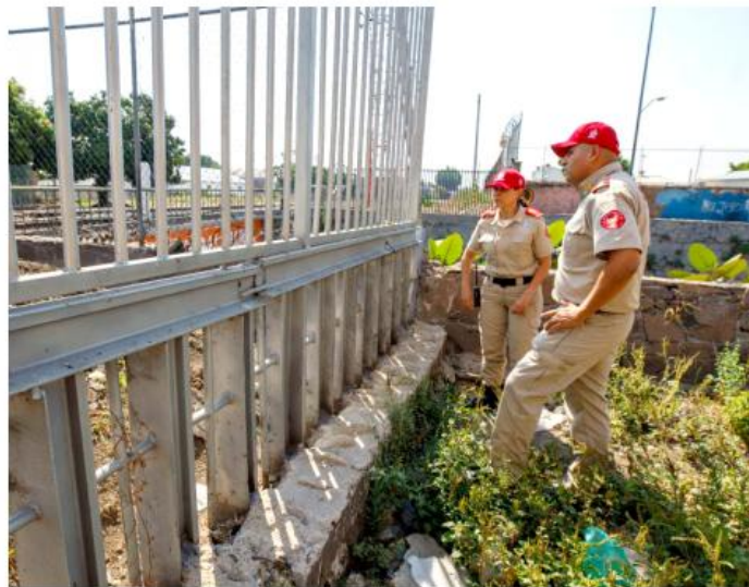
Se mantienen labores permanentes de limpieza y desazolve en distintos puntos.
