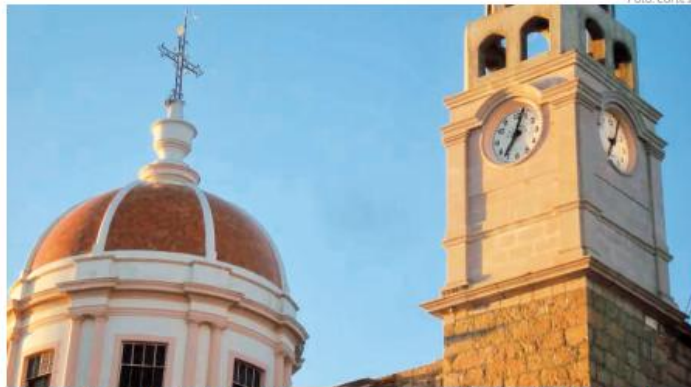
Iglesia de la localidad de Mirandillas, que ahora se llamará Mirandilla, al igual que la localidad que está en España, en Extremadura.
