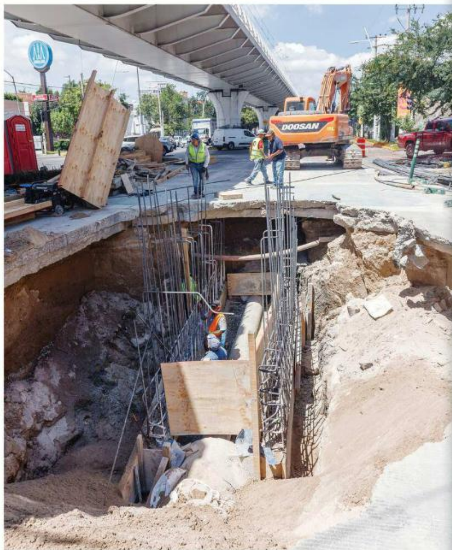
■ Los trabajos por parte del personal del SIAPA continúan desde el martes, por lo que la vialidad rumbo a Zapopan está cerrada a la altura de Jacarandas.
