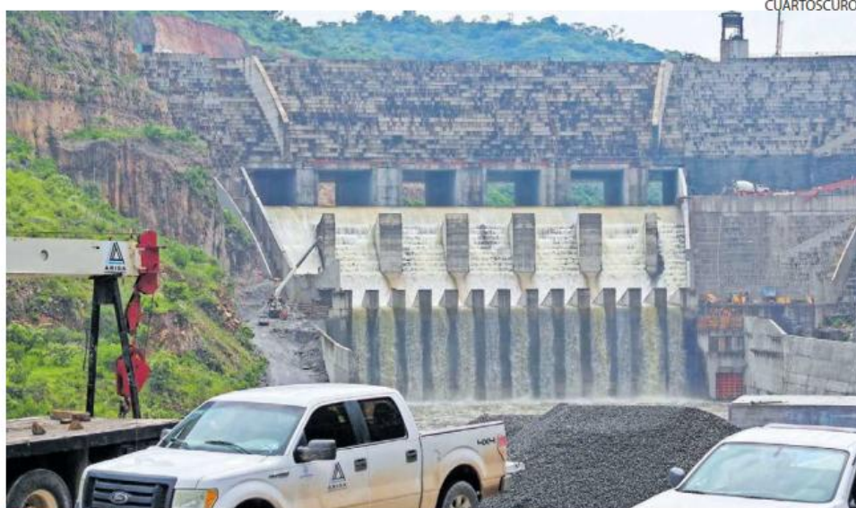
PRESA. También revisan obras complementarias para aprovechar El Zapotillo.
