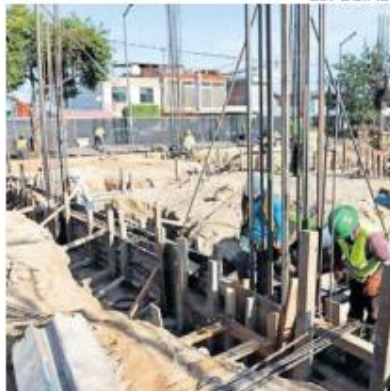
OBRA. Se notan los cimientos de la unidad médica municipal.
