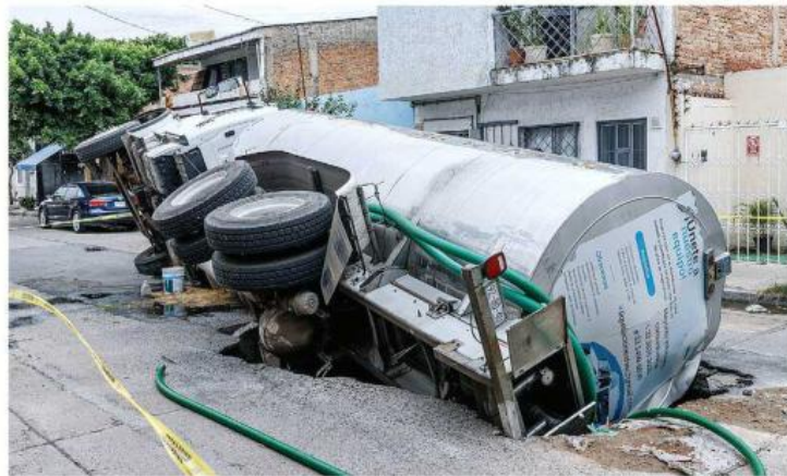
■ El accidente ocurrió en la Calle Fontaneros, al cruce con Avenida Presidentes.
