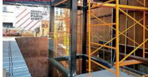
El interior está aún apuntalado y las escaleras eléctricas no se han colocado, de acuerdo con trabajadores.
