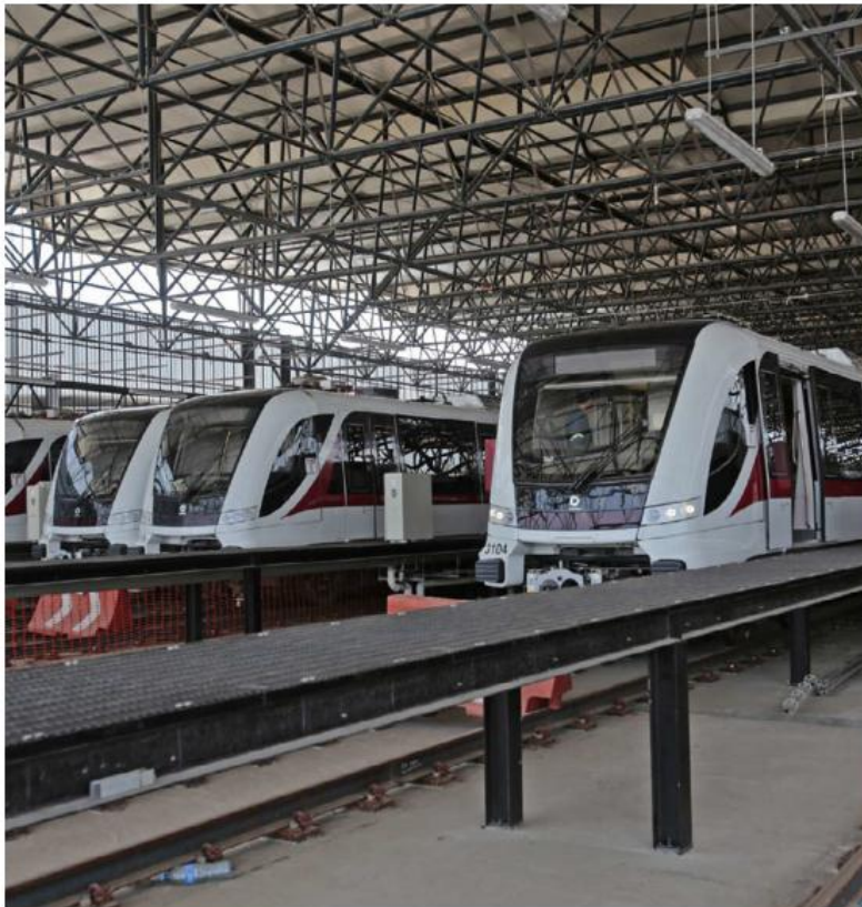
Realizan las pruebas de las instalaciones. FERNANDO CARRANZA
