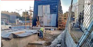
Los ingresos a la parada subterránea siguen en construcción y la obra aledaña tampoco ha concluido.
