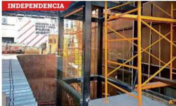
■ El interior está aún apuntalado y las escaleras eléctricas no se han colocado, de acuerdo con trabajadores.
