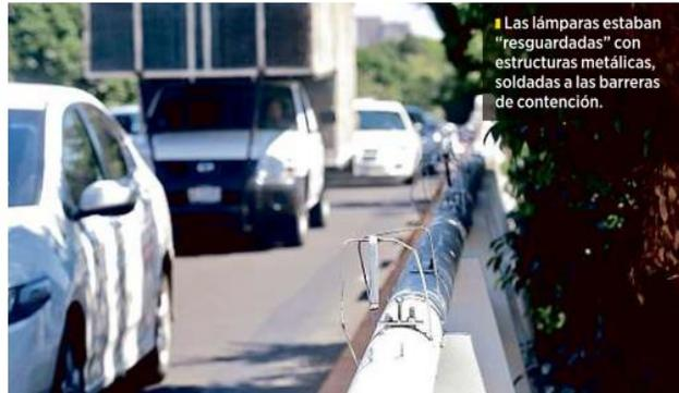
Las lámparas estaban "resguardadas" con estructuras metálicas, soldadas a las barreras de contención.
