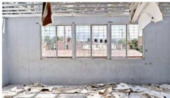
■ El plantel construido con materiales provisionales se encuentra en el Fraccionamiento Real del Valle.
