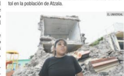
JOJUTLA. Una estudiante permanece junto a su escuela que se derrumbó.
