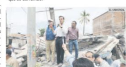
RECORRIDO. El Presidente habló a los pobladores de Jojutla sobre las ruinas de un edificio.
