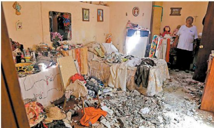
Un vecino de Atlixco mostró los daños que sufrió su hogar tras el sismo del martes.
