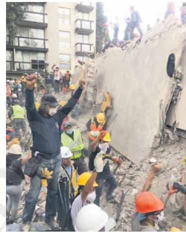
COLONIA LINDAVISTA. Entre las calles Sierra Vista y Río Bamba hay un edificio colapsado donde se tiene conocimiento de que permanecen atrapadas 12 personas, de las cuales una de ellas logró comunicarse por celular.
