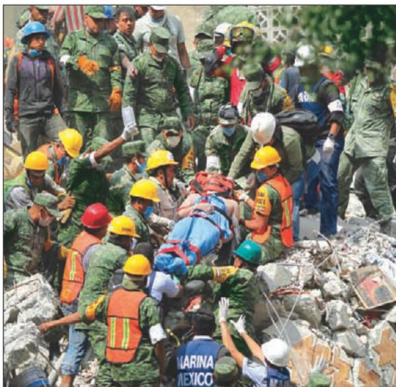
Un hombre es sacado con vida de los escombros del edificio derrumbado en Laredo y Ámsterdam, en la colonia Condesa, tras 22 horas de trabajos de rescate.
