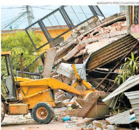
Trascabo remueve los escombros de un predio colapsado en Jojutla.
