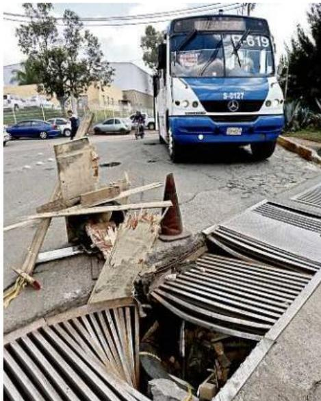
Esta alcantarilla en mal estado, debido al tráfico pesado, se ubica en Periférico Sur al cruce con Calle Hidalgo.
