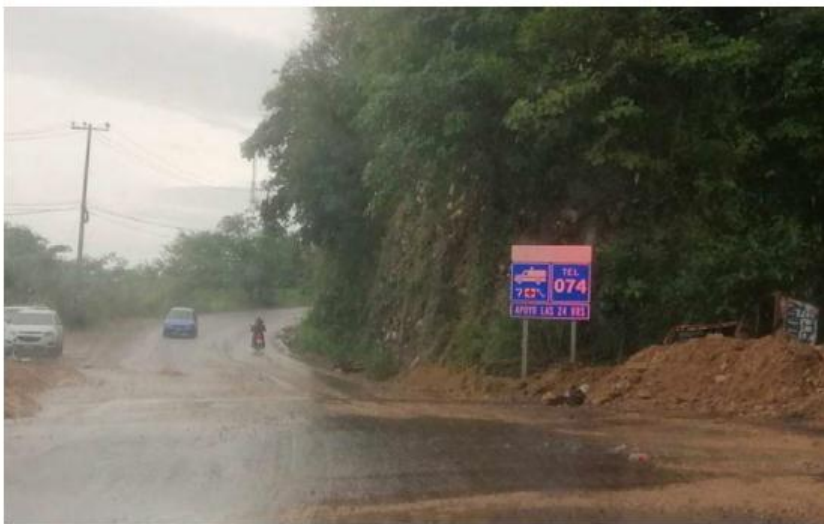
Lluvias en Puerto Vallarta afectó carreteras. ESPECIAL
