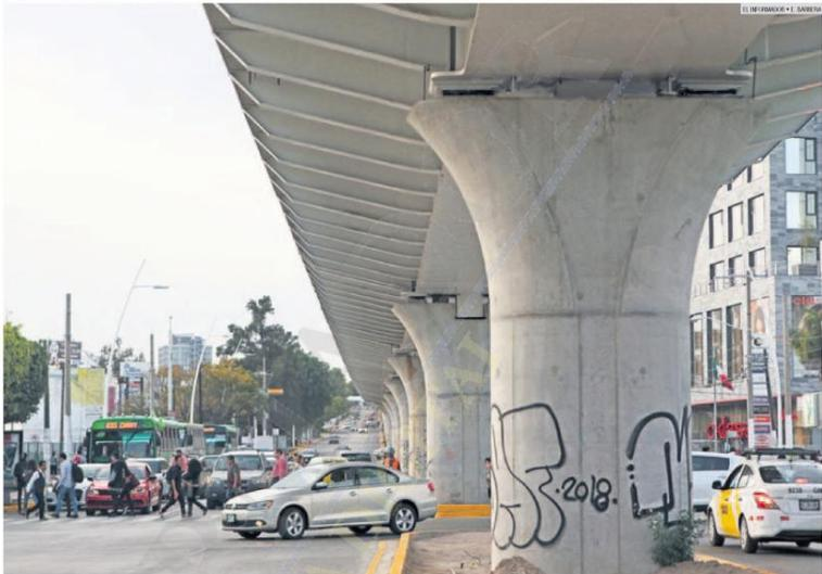
**SOLUCIÓN.** La SCT confirma que serán restituidas las mil 500 placas de neopreno, localizadas en la parte superior de las pilas que soportan las trabes metálicas por donde circulará el tren.
