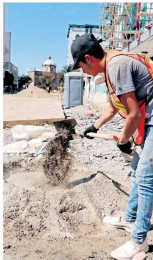
A marchas forzadas las obras alternas a la Línea 3. ANTONIO MIRAMONTES.
