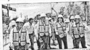
» AYUDÓ al Gobernador Jorge Aristóteles Sandoval y al titular de la SCT, Gerardo Ruiz Esparza supervisar trabajos de la Línea 3 del Tren Ligero, en la Glorieta de La Normal.
