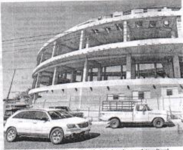
Se invirtieron 72 mdp para la construcción de 3 pisos de un recinto cultural
