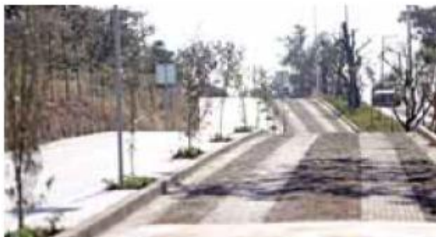
Grupos ambientalistas acusan que la avenida se construyó para privilegiar a dos empresas inmobiliarias. AYUNTAMIENTO DE ZAPOPAN
