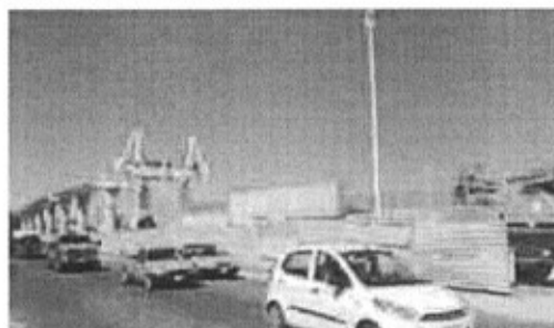
AÚN NO. En la Central Nueva todavía no instalan la 'caja' de la estación.
