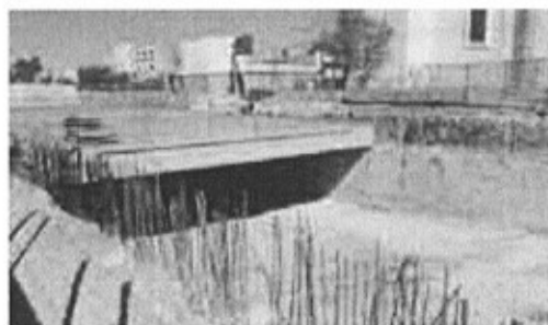
AHÍ LA LLEVAN. En la estación Plaza de la Bandera, punto en el que comenzará a salir a la superficie el tren, el túnel ya está listo.
