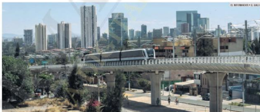
PROMESA. La SCT afirma que las obras civiles terminarán en julio, el trabajo electromecánico finalizará en agosto y luego iniciarán las pruebas.
