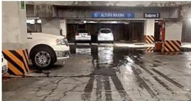
■ Las filtraciones en el estacionamiento, que son visibles en otros pisos, impiden utilizar 60 cajones del nivel -4.
