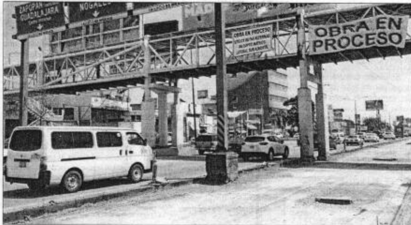
Algunas obras con atraso en pagos y que forman parte de contratos por 150 millones de pesos son avenida Aviación, López Mateos Sur y carretera a Colotlán ■ Fernando Carranza
