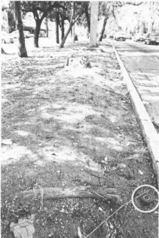
> En diversos tramos los aspersores no funcionan (círculo), riegan hacia el pavimento, están desconectados o no hay agua.
