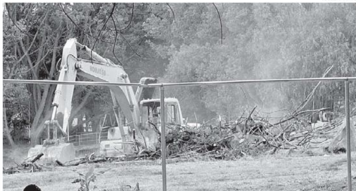
En el parque del Deán se realiza la ampliación de un depósito, como parte del megaproyecto
