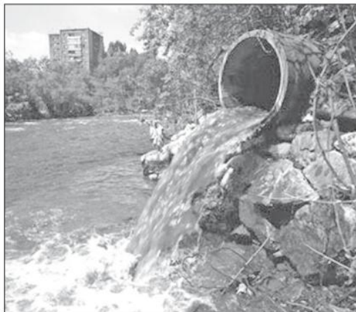
GRAVEMENTE la contaminación pluvial por residuos industriales.
