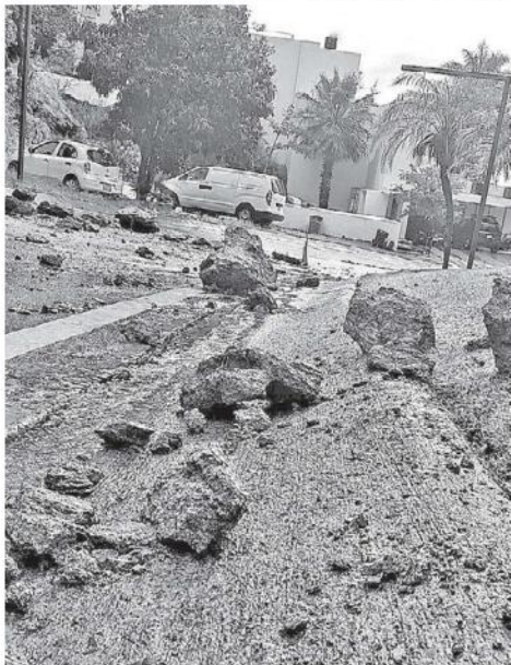
La precariedad del suelo y la alta pendiente ocasionan deslizos
