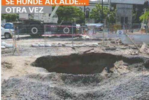
CENTRO HISTÓRICO. Ayer se reabrió el socavón que en mayo se tragó una retroexcavadora en Paseo Alcalde. La SCT señaló que el hoyanco se originó debido a un proceso de bombeo hidráulico relacionado con la Línea 3 del Tren Ligero. Por la tarde se trabajó en rellenar el hoyo para que quedara cubierto. Martha Hernández Fuentes ZMG 3A
